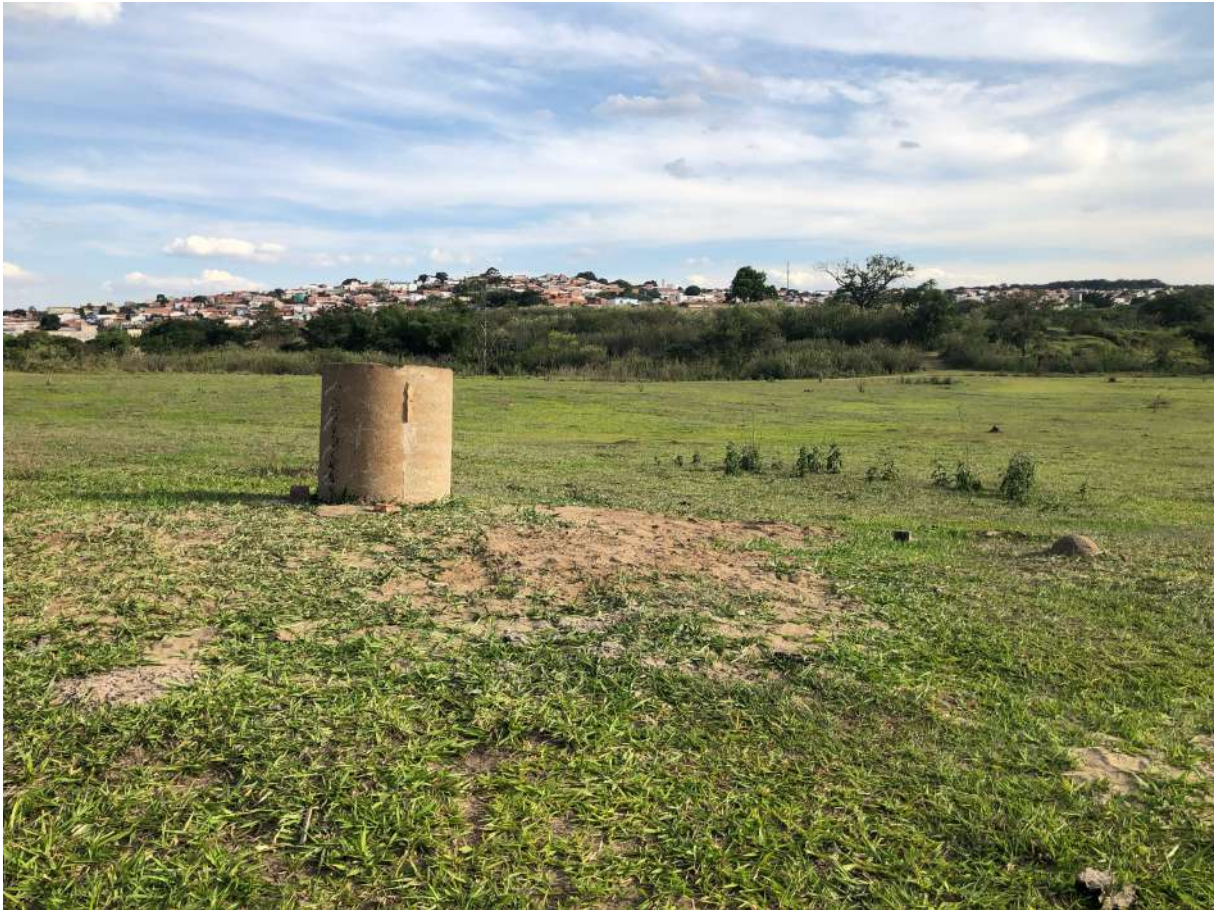
Figura XLI: Visão da área atualmente. Tubo de concreto protegendo acesso ao poço PM-01 Novo
