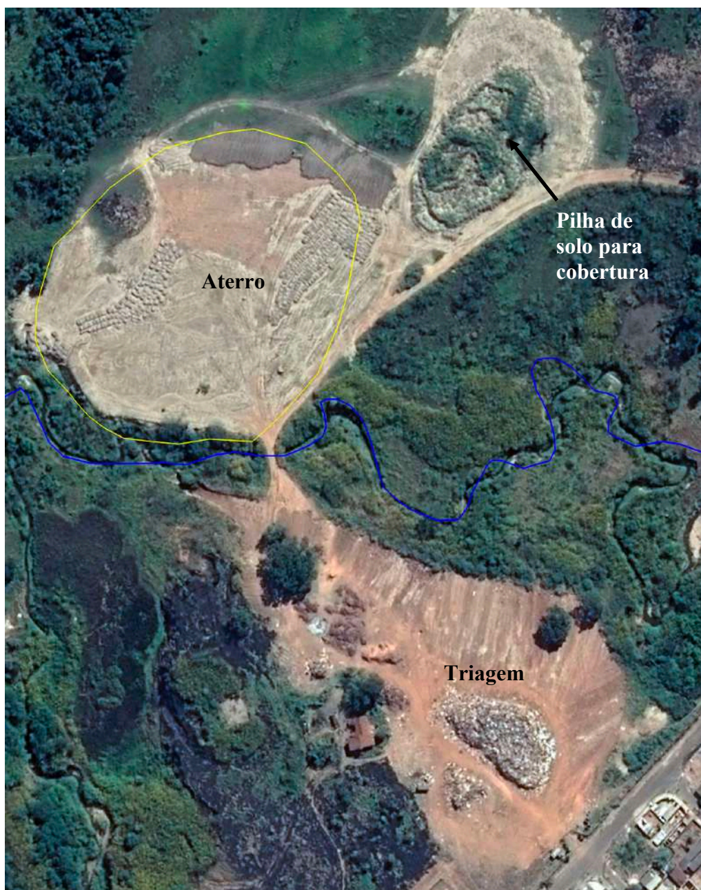
Figura XII: Imagem da área do Aterro do Sítio Cocais com solo de cobertura – data 18/05/2013 Fonte: Google Earth
