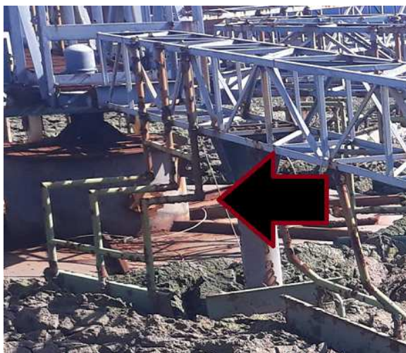
Figura 4: Aletas Direcionadoras do Lodo
