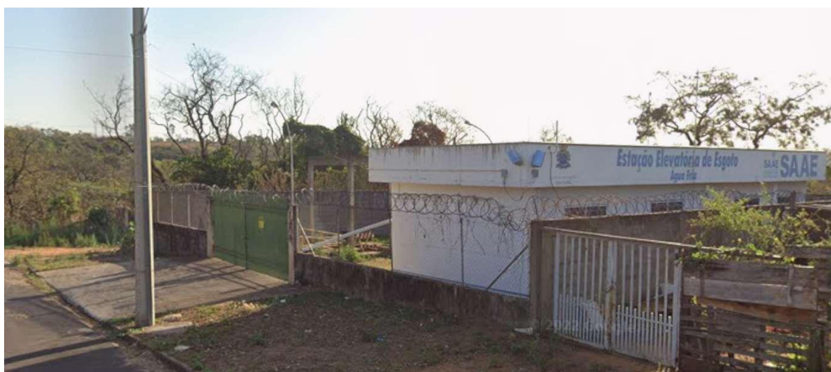
Imagem 1: Fachada da EEE Água Fria
