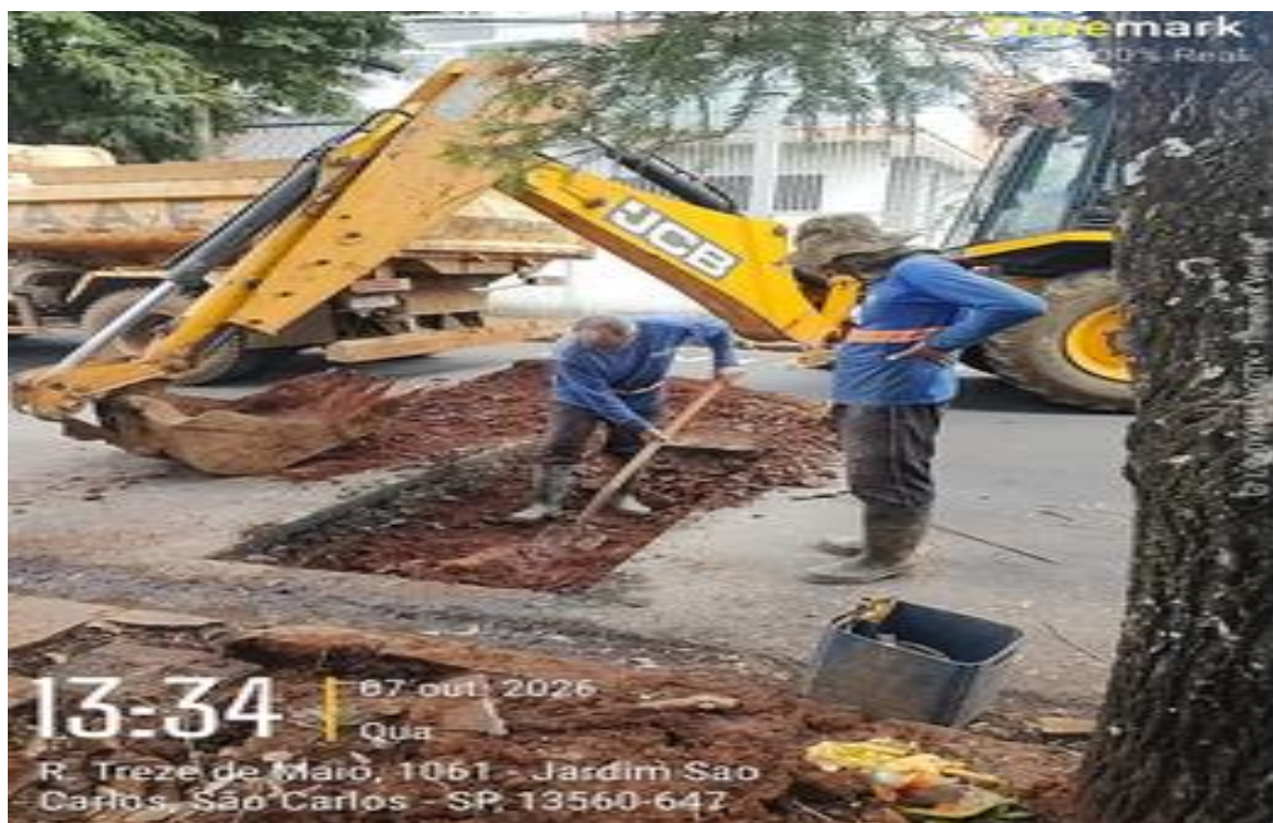
Rua Treze de Maio, 1061 – Manutenção da rede
