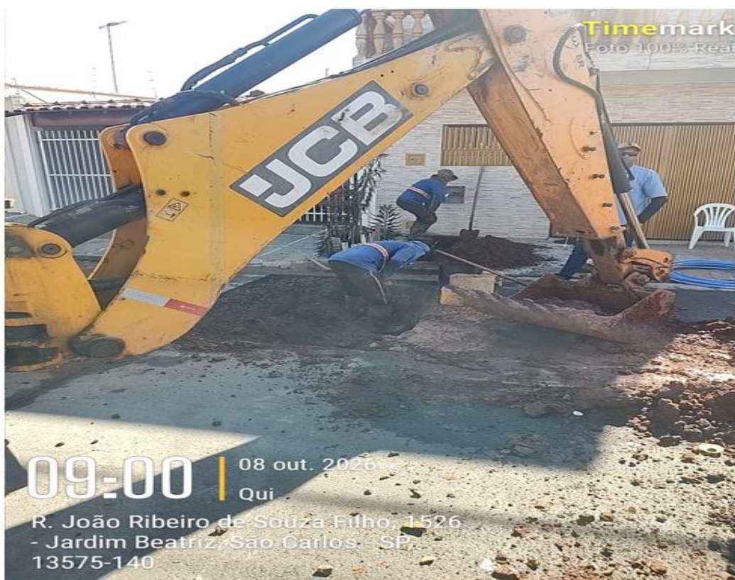
João Ribeiro de Souza Filho nº 1525 Manutenção de Rede de Água
