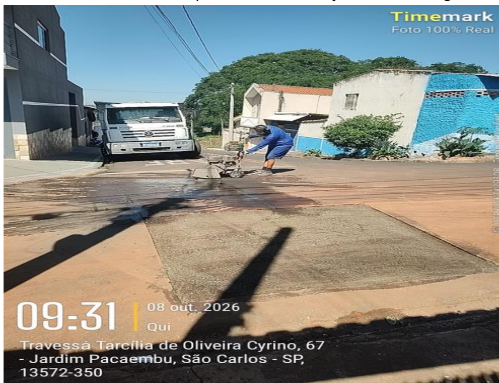
Travessa Tarcília de Oliveira Cyrino nº 85 Manutenção de Rede de Água
