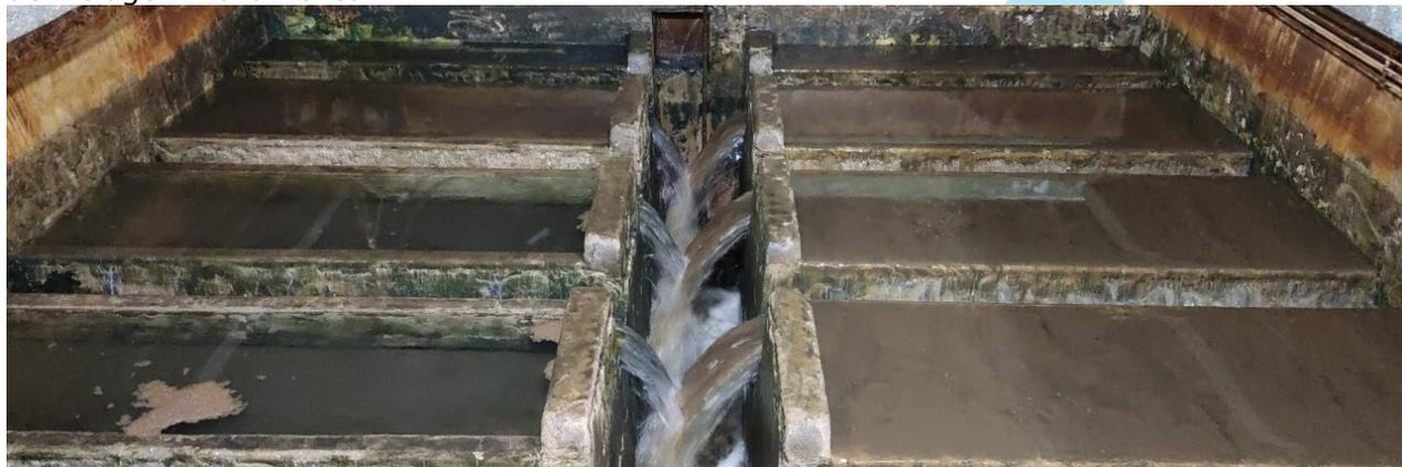
*Figura 5 - Diferença entre as águas da retrolavagem iniciada (à direita) e finalizada (à esquerda)*
